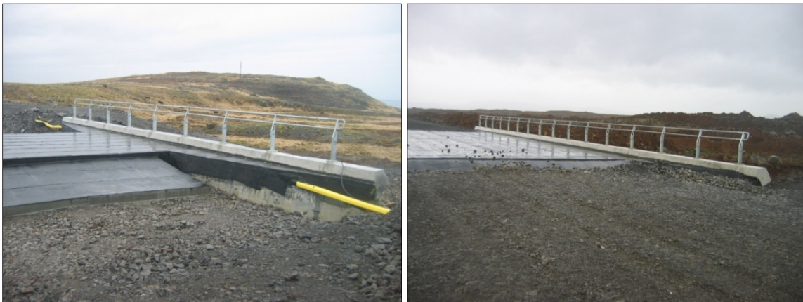
Mynd 1. Myndir frá Reykjanesbraut, sýna núverandi verklag við einangrun brúardekks. Myndirnar eru frá verktaka.
